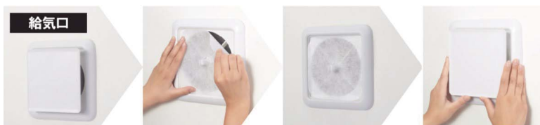
給気口のカバーを外し、給気口内部に、フィルターを両面テープで貼り付けます。
