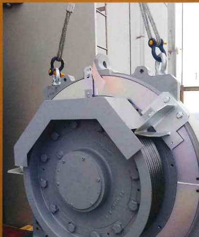
昇降機吊上移動(沖縄県宮古島)
